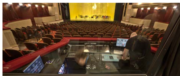
Eingehauste Videoregie, davor der neue offene Tonplatz mit SSL System T
